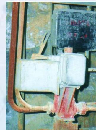
**Особенности конструкции:** сменные элементы проточной части («седло и шибер»), ручной дублёр, полнопроходный, уплотнительные поверхности наплавлены сплавом повышенной стойкости, плавающий шибер с подпружиненными уплотнениями седла, встроенное устройство защиты электродвигателя. Ремонт производится путём замены элементов проточной части (седло, шибер, уплотнительные элементы). Расчётный срок эксплуатации – 200 тыс. часов.
