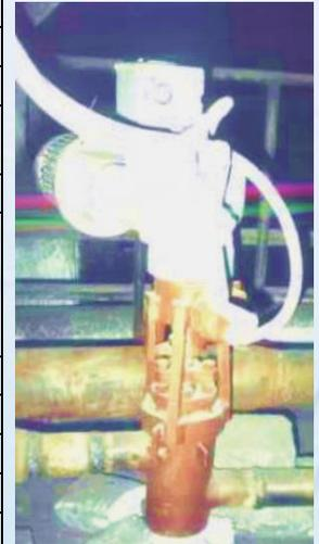
**Особенности конструкции:** клапан запорный, самоуплотняющийся при остывании после закрытия, со сменными элементами проточной части, защитой корпуса от размывания, имеет байонетное соединение «бугель – корпус». Расчётный срок эксплуатации 200 тыс. часов.
