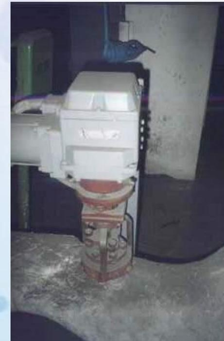
**Особенности конструкции:** сменные элементы проточной части, защита корпуса и выходного патрубка от размывания, не подвержен заклиниванию при попадании мех. частиц (грата), байонетное соединение «бугель – корпус», электропривод типа МЭО. Ремонт производится без демонтажа клапана из трубопровода путем замены элементов проточной части («седло-затвор», сальник), Общий срок эксплуатации - не менее 200 тыс. часов.
